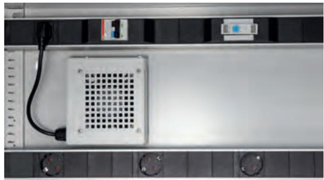
Temperaturgesteuerter Lüfter und Zentrale Masterleiste beim Comfort-Schrank
